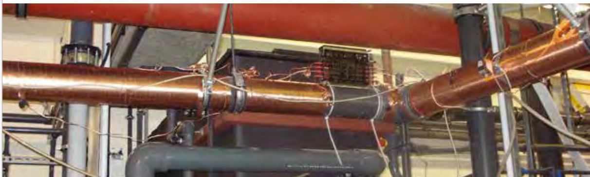
Vulcan S250 bei der Behandlung der Hauptwasserleitungen für den Pool- und Spa-Bereich von Meridan
