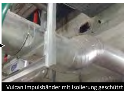
Vulcan Impulsbänder mit Isolierung geschützt
