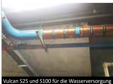
Vulcan S25 und S100 für die Wasserversorgung
